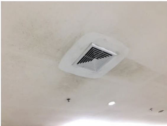
“เชื้อรา” Silent Killer ของงานอาคาร เนื่องจากความชื้นสัมพัทธ์สูง
