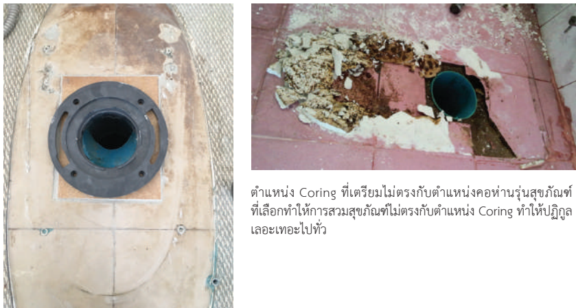
การติดตั้งแผ่นประกัน Floor Flange ป้องกันรั่ว
