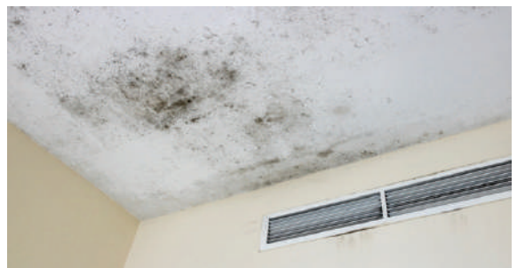
“เชื้อราดำ” เจริญเติบโตอย่างหนาแน่น (อย่างไม่สม่ำเสมอ) บนผิวฝ้า
