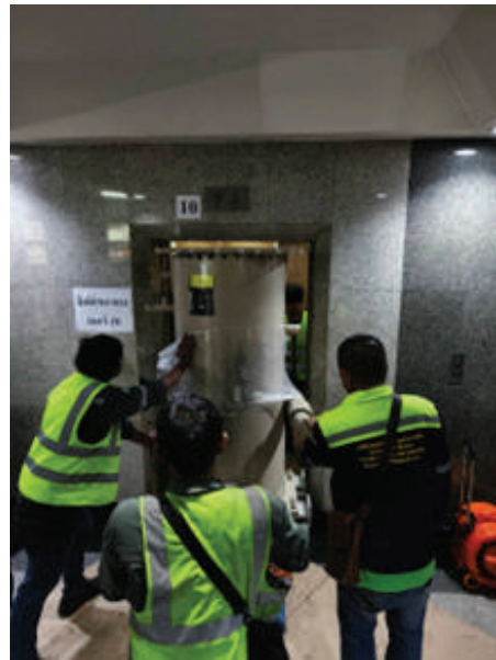
รูปที่ 7 การถอดแยกชิ้นส่วนและการเคลื่อนย้าย Knockdown Chiller
