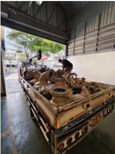
รูปที่ 7 การถอดแยกชิ้นส่วนและการเคลื่อนย้าย Knockdown Chiller
