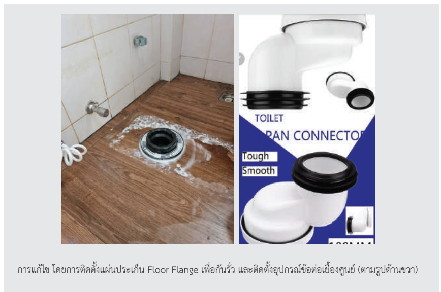
การติดตั้งแผ่นประกัน Floor Flange ป้องกันรั่ว
