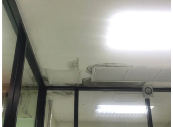
“เชื้อราดำ” ที่เกิดจากการควบแน่นของการเกิดหยดน้ำบนท้องฝ้า
