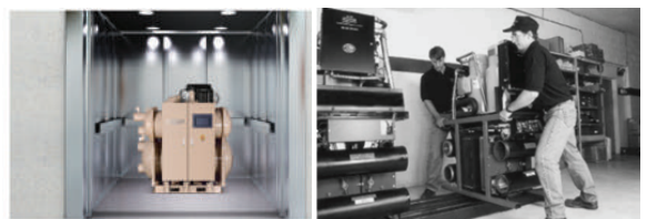
รูปที่ 4 การเคลื่อนย้ายและประกอบ Modular Chiller
