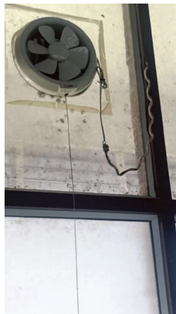
ปัญหาเชื้อราจากเพิ่มอัตราการระบายอากาศจนอาคารมีสภาวะ Negative Pressure แรงดัน (-) อันเป็นเหตุให้เกิด “เชื้อราเจริญเติบโตกระจายทั่วอาคาร”
