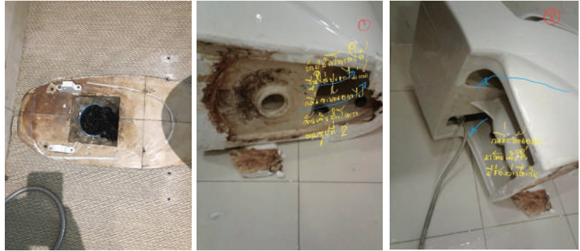
ปัญหาการติดตั้งผนังงานที่ไม่ถูกต้อง ไม่มีการรอง floor flange ประกันแหวนรอง เพื่อป้องกันรั่ว ทำให้ปฏิกูลรั่วเลอะขอบสุขภัณฑ์
