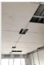
ภาพที่ 7 ระบบการติดตั้งระบบ Ceiling Radiant Cooling ที่ศูนย์ประชุมแห่งชาติ
